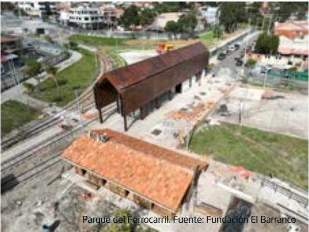
Parque del Ferrocarril. Fuente: Fundación El Barranco
